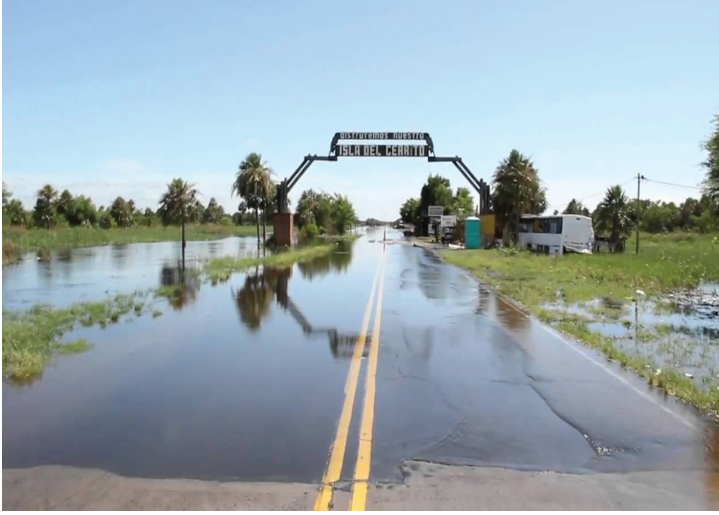
Ruta de acceso a Antequera anegada en épocas de crecida del Río Paraná
