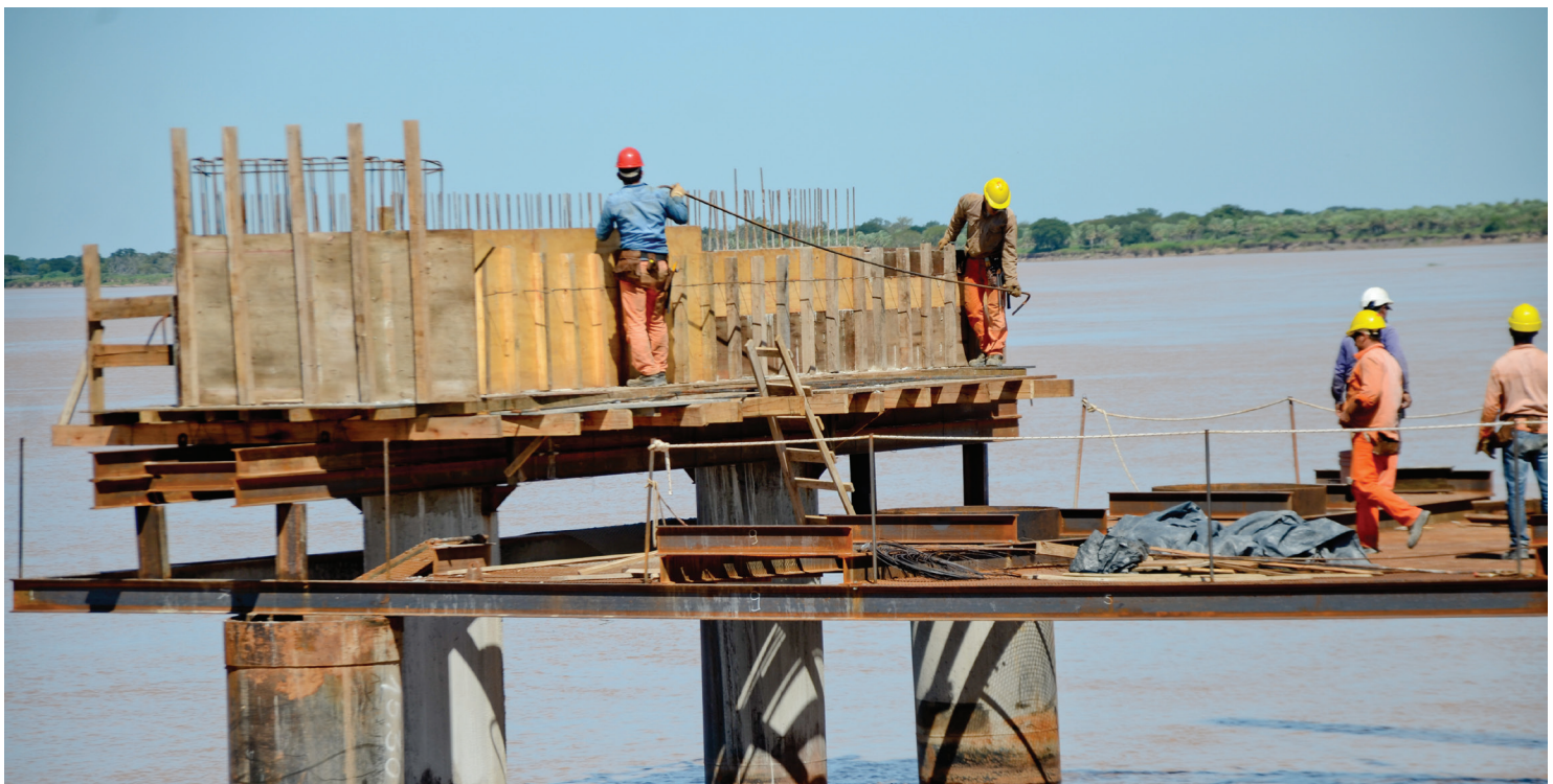
Obra en ejecución Puerto Las Palmas
