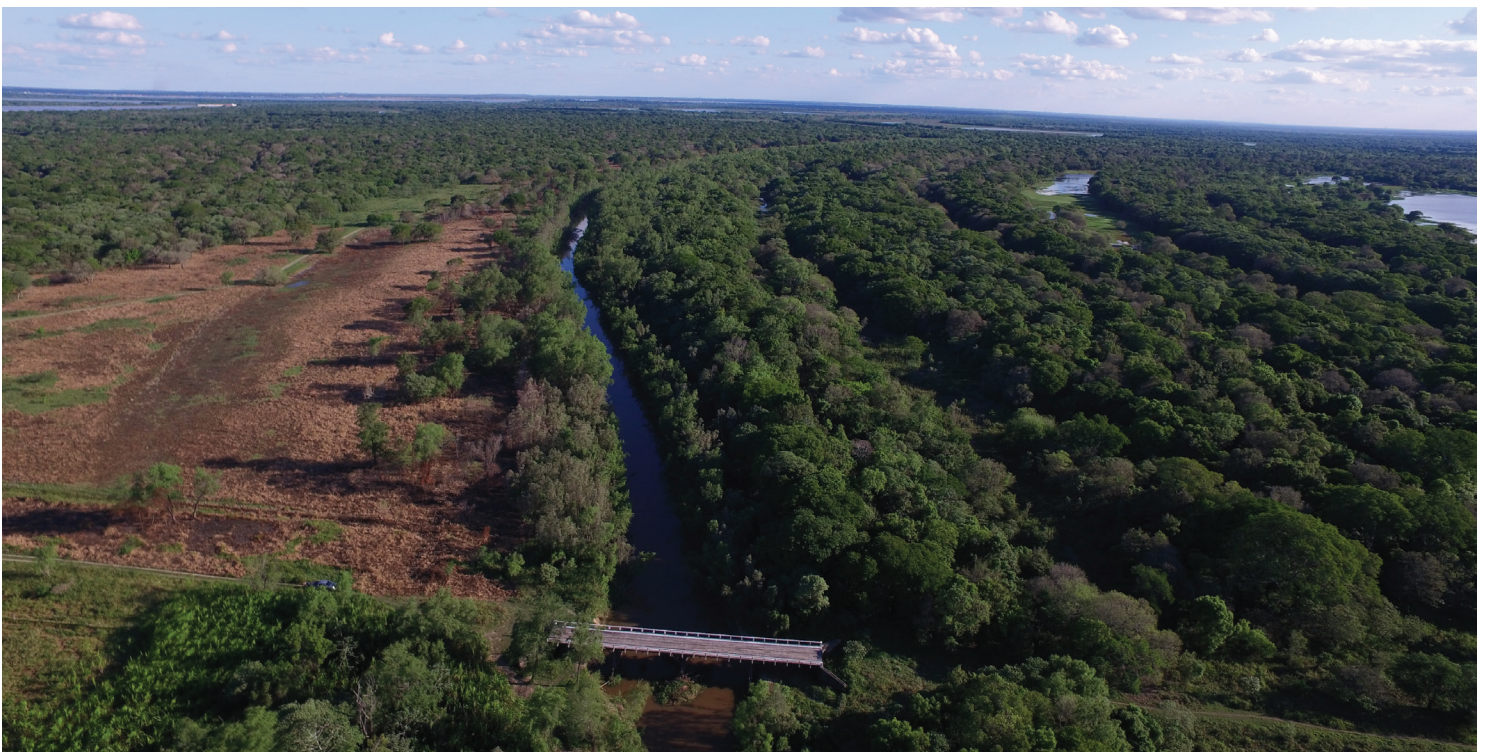
Puente de Conexión Isla del Cerrito - Las Palmas. Obra no concluida
