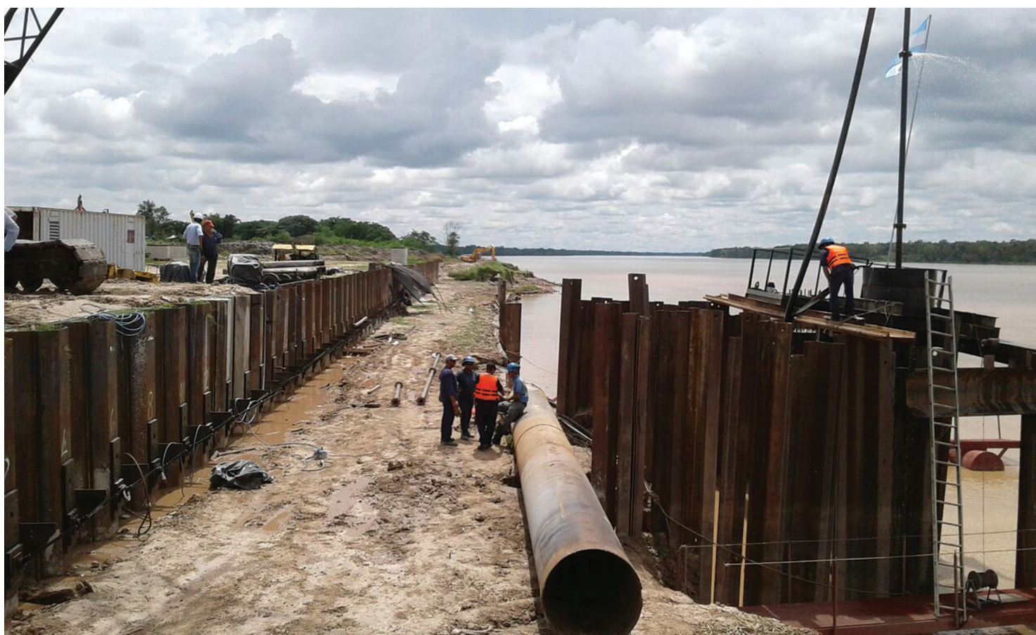
Obra Puerto Las Palmas
